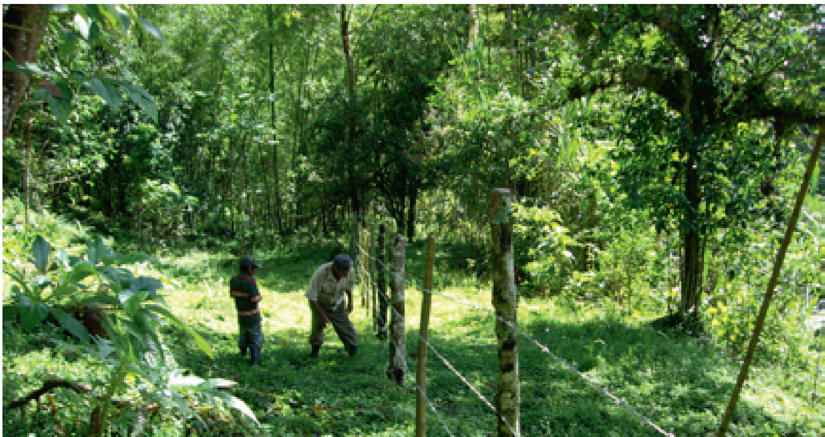
Campeñinos instalando cercas para las franjas protectoras de las cuencas
